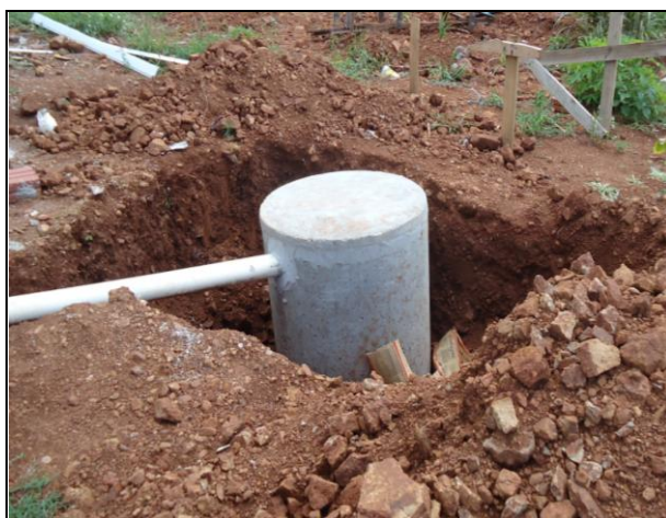
FOTO 05 – Instalação de Fossa Séptica
